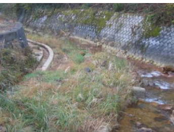
②取水口から下流へ向かう 水路
